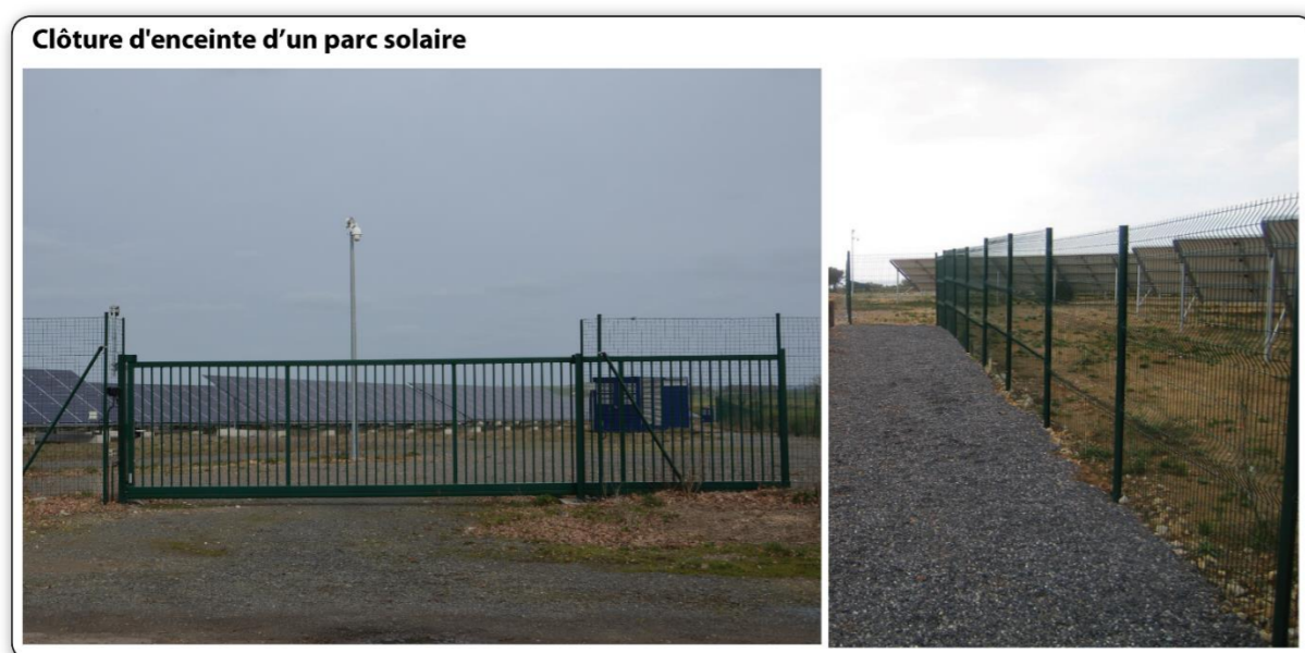
Clôture de sécurité
